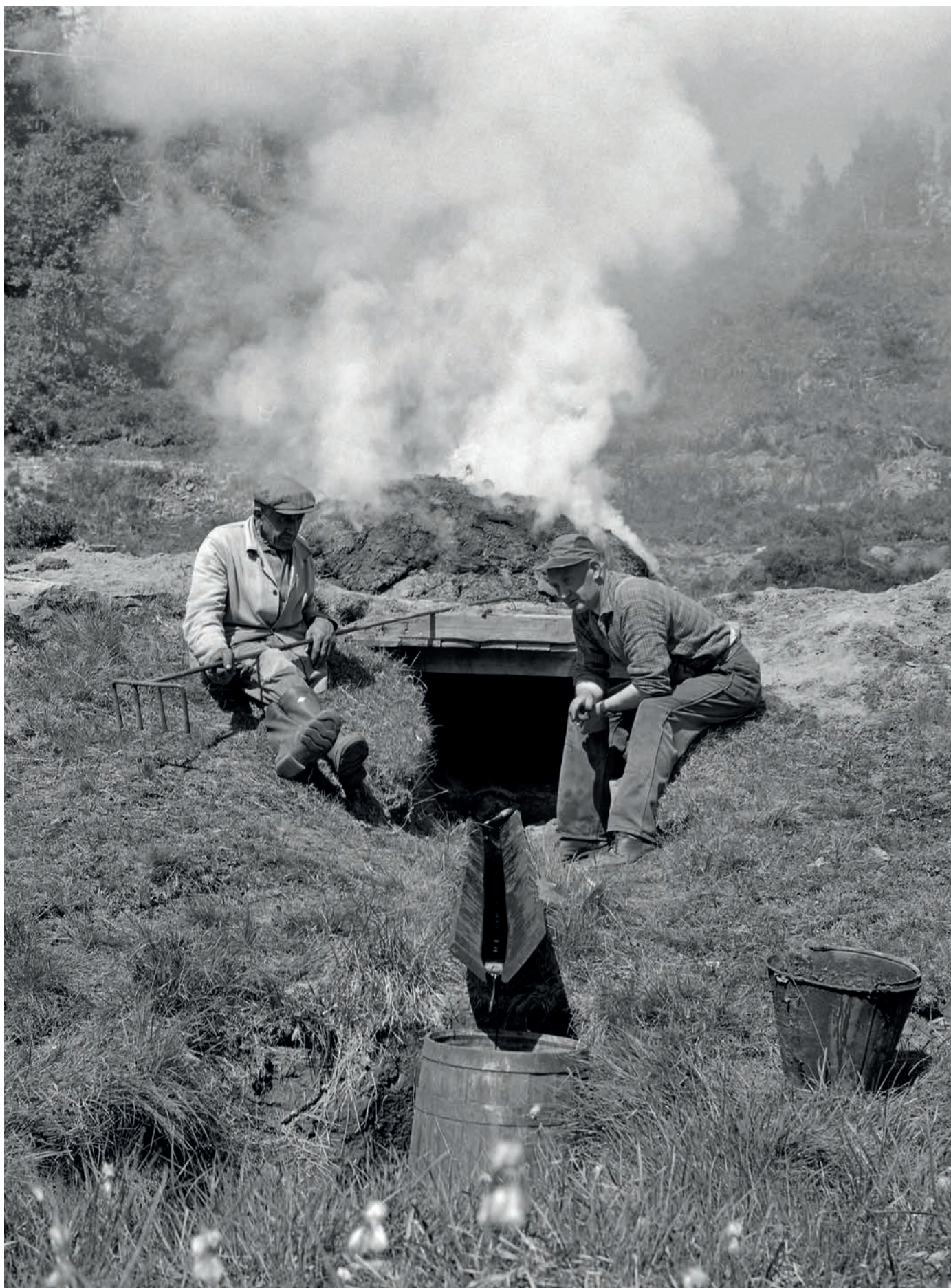
Et eksempel på tjæreproduksjon i nyere tid. På dette anlegget tappes tjæren ut av mila via en renne som fører tjæren bort til tønna, som er plassert lavere i terrenget. Motivet er fra Nordmøre. Foto: Tore Fossum, Anno Norsk skogmuseum. CC BY-ND
