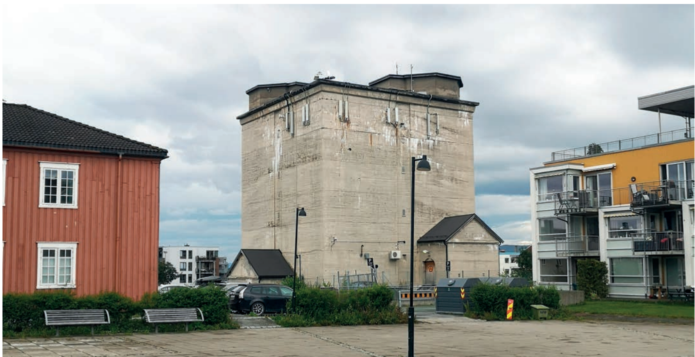
Lager- og tilfluktsbunker med plattform for luftvernkanoner på toppen. Til venstre ligger et av forlegningshusene, til høyre ligger en nyoppført boligblokk. Foto: Kristoffer E. Grini
