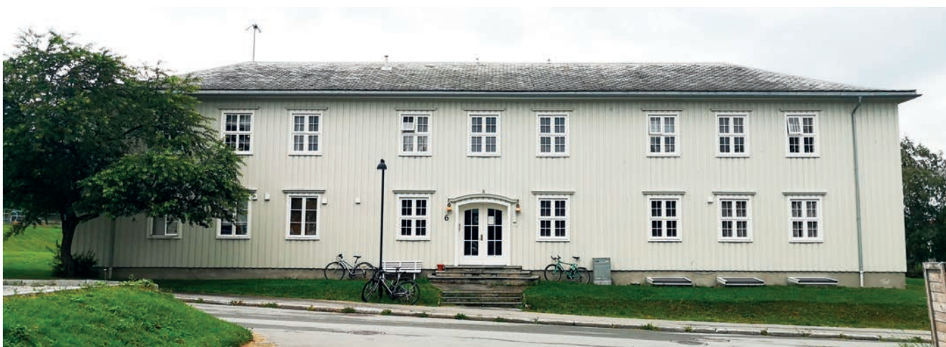
Et av forlegningshusene i Persaunet leir, sannsynligvis brukt av et helt ubåtmannskap mens de lå i havn. I dag leiligheter. Foto: Kristoffer E. Grini
