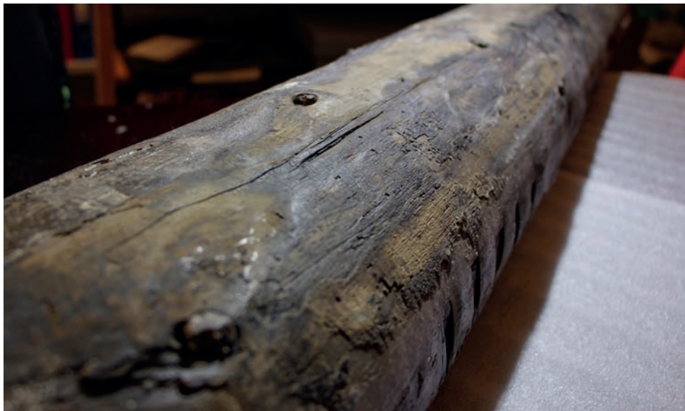
En laftestokk, trolig fra 1000-tallet, gravd fram på Folkebibliotekstomta i 1971 og i dag oppbevart ved NTNU Vitenskapsmuseet. Siden denne er konserverert og gjennom det bevart, kan vi fortsatt studere den i dag og oppdage nye detaljer, som at det er ikke spor etter meddraging og mosefar på den. Slike detaljer er det ikke mulig å se ut fra dokumentasjonen fra 1971. Foto: Per Steinar J. Brevik
