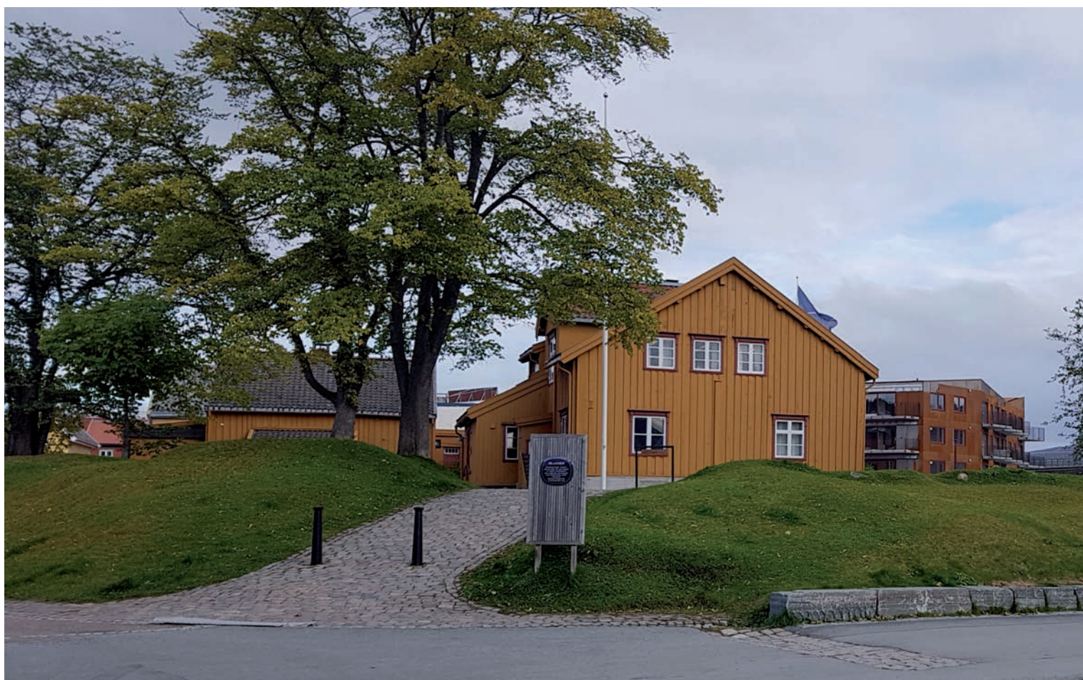
Skansen 2019. Del av forstøtningsmur som vender mot øst og Tromsøsundet. Fredningsgrensen strekker seg nå over den brolagte veien. Foto: Keth Lind, Norges arktiske universitetsmuseum – UIT
