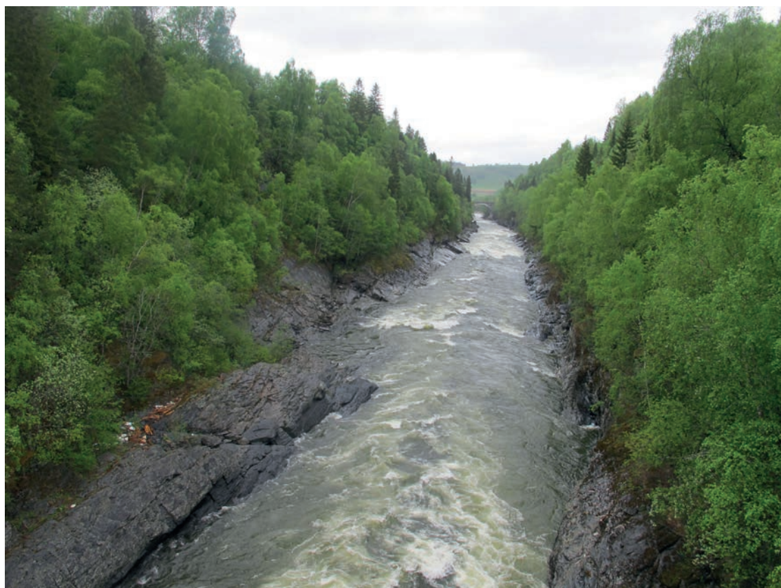
Gaulfossen mellom Hovin og Foss i Melhus kommune er et egenartet natur- og kulturmiljø. Den moderne jernbanebrua sees mot nord. Foto: Kjell A. Brevik
