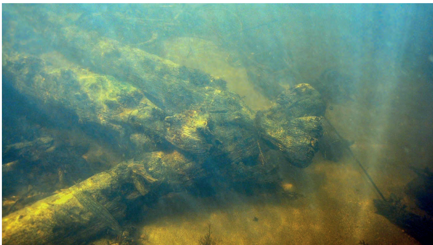
Under: Elgeseter bro, brokar E. Foto: Øyvind Ødegård, NTNU Vitenskapsmuseet
