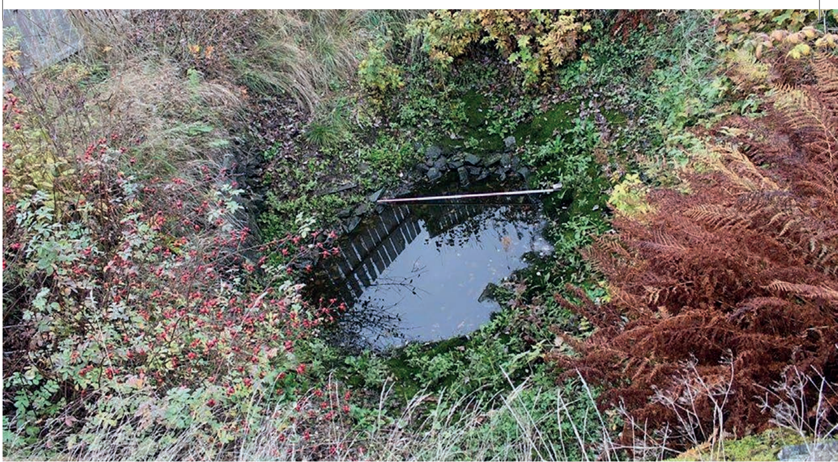
Brønnen fotografert høsten 2013 i sammenheng med befaring. Foto: NIKU
