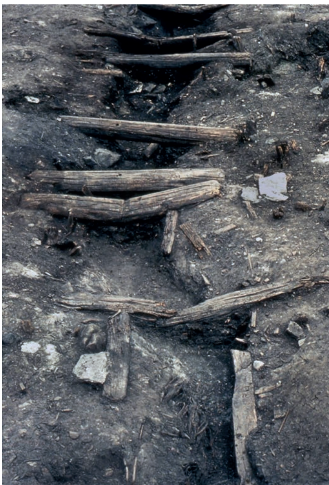
Dreneringsrenne fra 1100-tallet som har ligget under en passasje inn til en privat bygård på Folkebibliotekets tomt. Foto: Axel Christophersen, NTNU Vitenskapsmuseet
