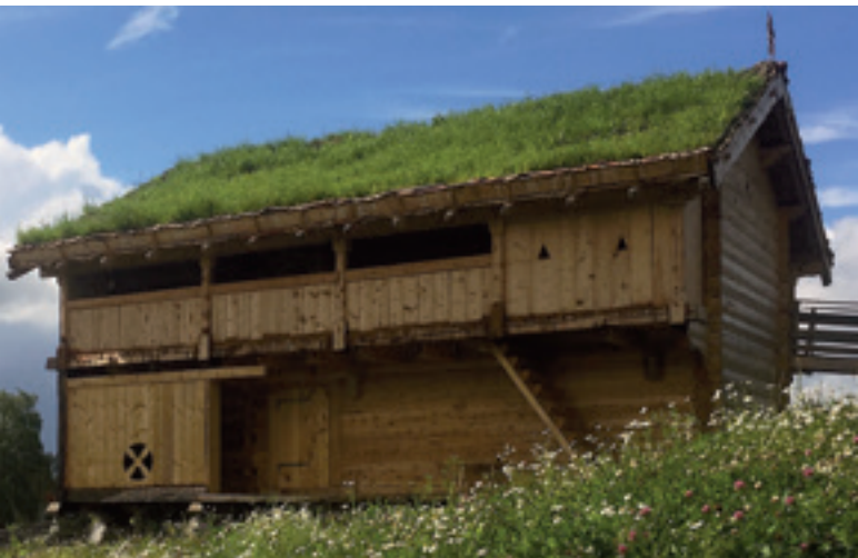
Loftet, med utvendig trapp og svalgang i 2.etasje. Foto: Per Steinar Brevik, SNK
