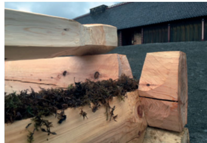
Etter hvert fikk vi taket på tømmerknutene. Her ser vi også isolasjonen (husmose/etasjemose) mellom tømmeret. Foto: Per Steinar Brevik, SNK
