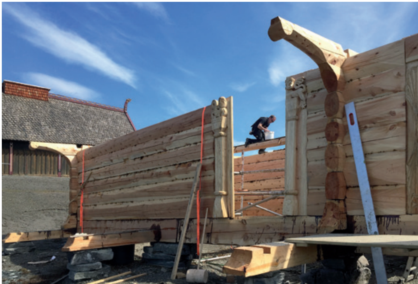
Loftet settes opp på tomte etter å ha blitt tømret opp innendørs. Foto: Per Steinar Brevik, SNK
