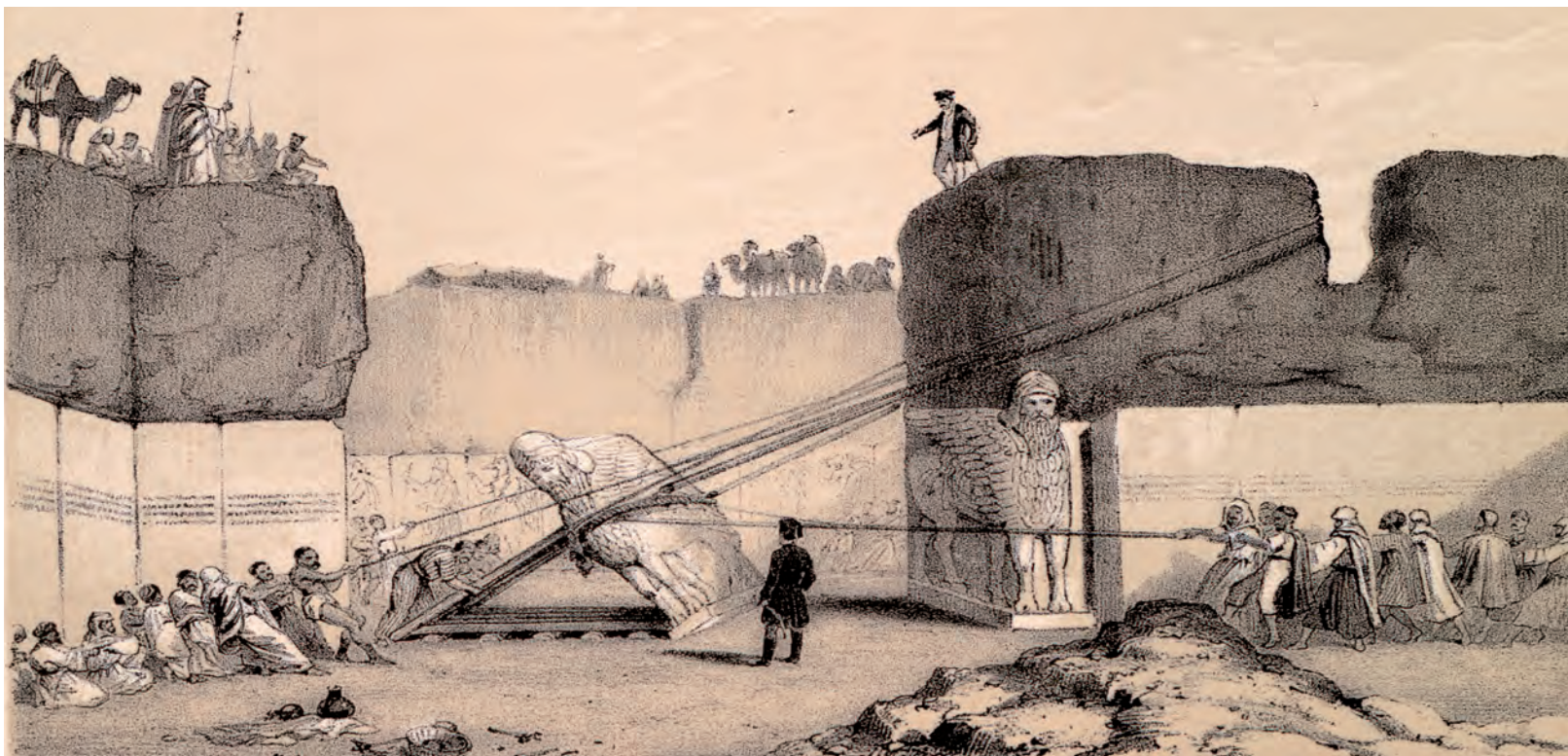
Her blir de store bevingede okse- eller lamassu-figurene tatt ned og klargjort for å kunne fraktes til London. Etter Nineveh and its Remains (1849)
