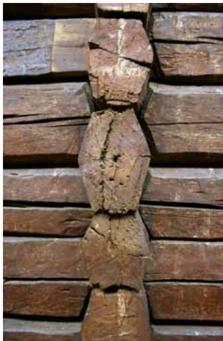
Denne forma på laftenden heiter i Gudbrandsdalen «hesthuggunov» og er eit norsk laft. Stokkendane på russiske laft var, og er, runde. Foto Sergej Agisjev
