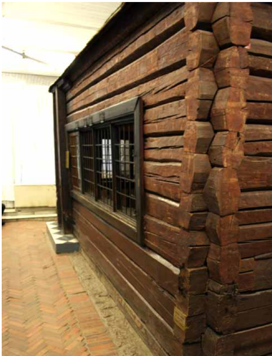
Tverrenden på huset. Her ser ein vernebygget som er bygd utanpå. Foto Sergej Agisjev
