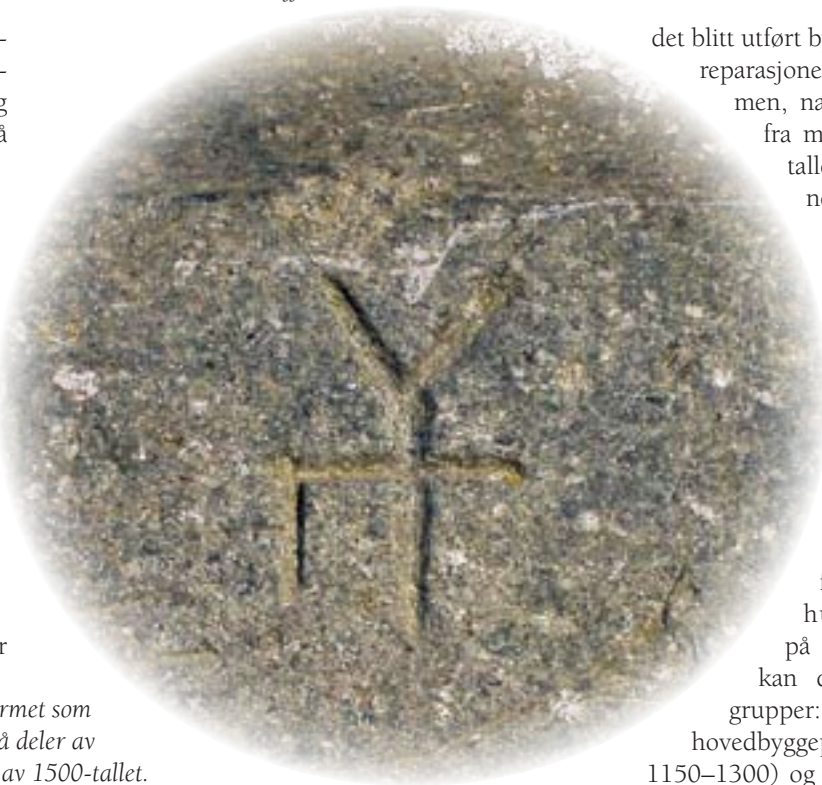
Steinhuggermerker på veggflatene i Nidarosdomen fra andre halvdel av 1200-tallet. Merkene kunne ha ulik utforming, og geometriske figurer, bokstaver, runer og verktøy var motiv som ofte ble brukt. Foto K.H. Kristoffersen
