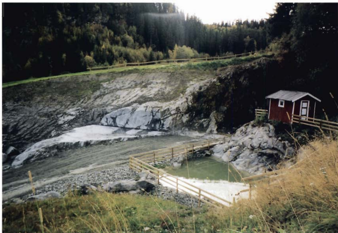
Nytt og gammelt brudd side om side. Det gamle steinbruddet ligger til høyre og det nye til venstre. I kulturlandskapet bakenfor ligger masse fra bruddet, som er blitt jevnet ut og slik har gitt grunneieren mer dyrkbar jord. Foto Andreas Berg
