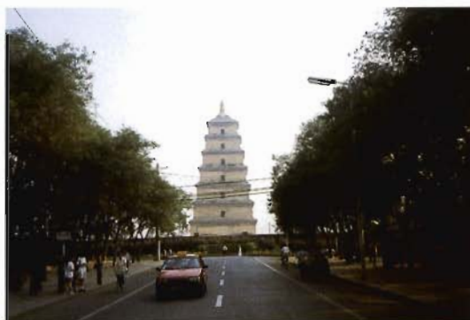
Den Store Vildgåspagoden ligger for enden av gaten Yanta Lu i utkanten av Tang-dynastiets Xi'an. Pagoden tilhører Da Cien-templet, anlagt i 647 e.Kr. Pagoden er kraftig restaurert flere ganger, og regnes blant Xi'ans betydeligste kulturminnesmerker. Foto A. Christophersen
