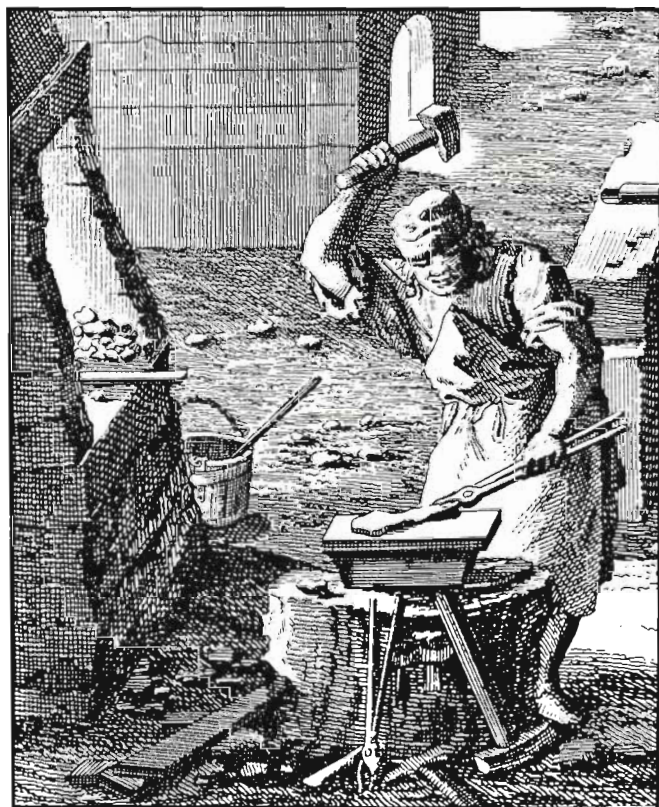
Jernsmed i arbeid. Utdrag av illustrasjon i E. Swedenborg: De Ferro, 1734.
