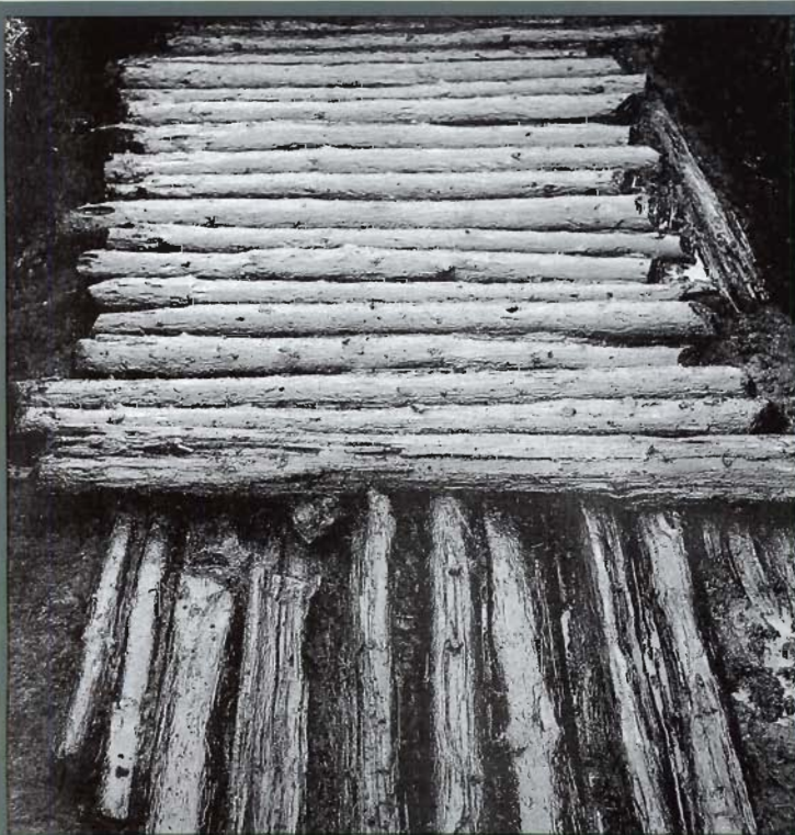
Eksempel på brolegning med tverrlagte stokker i brodekket i en av kavlebroene på Fisknes. Stokkene i brodekket hviler på et underlag av langsgående stokker lagt i hele veiens bredde. Foto: O. Farbredd.
